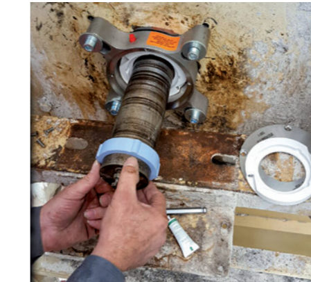
RotorCup und RubberBoot montiert.
